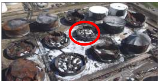
Figure 2. Quinze réservoirs détruits par l'incendie. Le feu a pris naissance au niveau du réservoir entouré d'un ovale rouge
